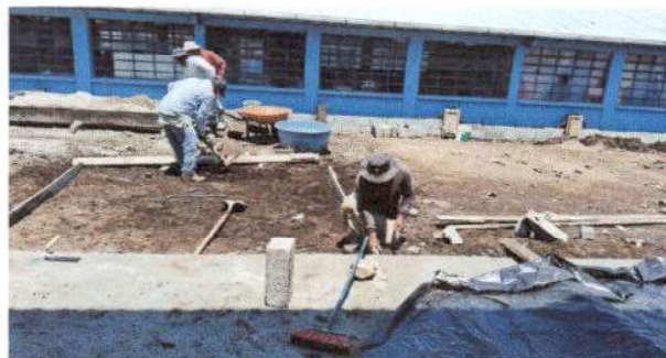
Nivelación de tramo de terreno para la colocación del siguiente cuadro de pavimento y repello de la misma para su nivelación y tallado.
