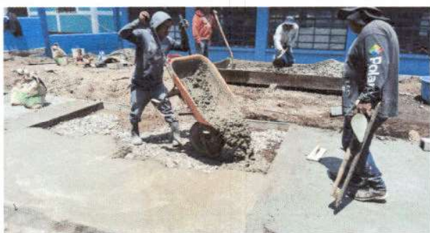
Preparación de mezcla y distribución en los cuadros de pavimento, con el material; arena, piedrín y cemento
