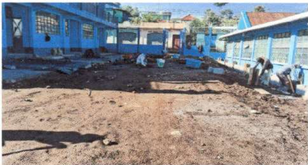
Inicio de pavimento de las aulas del Centro Oficial de Preprimaria Bilingüe anexa a Escuela Oficial Rural Mixta, Aldea Sicabe Bella Vista,
