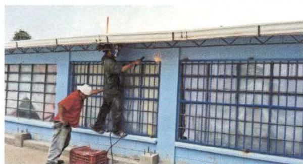
Terminado de colocación de los nuevos balcones de ventanas de las aulas correspondiente con material de; hierro entorchado, angulares y electrodos
